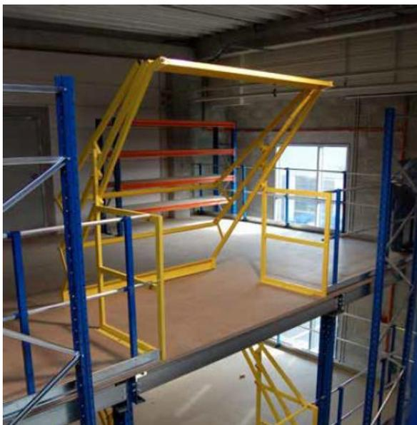
Systèmes de barrière écluses ou d'ouverture/fermeture asservie au droit de toutes les zones de chargement-déchargement, en complément de garde-corps normalisés fixes (placés à une hauteur de 1,10 m et comportant au moins une plinthe de butée à 15 cm, une main courante et une lisse intermédiaire à mi-hauteur) continus autour de la plateforme de stockage.
